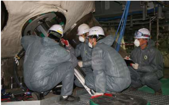
Zkouška vířivými proudy pro potrubí SG
