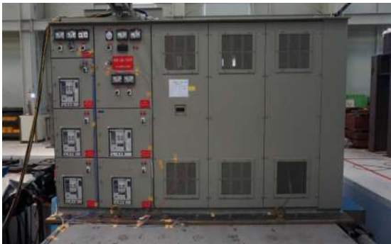
LV SWITCHGEAR
